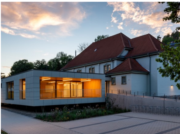
Stadthalle Haiterbach nach der Sanierung
