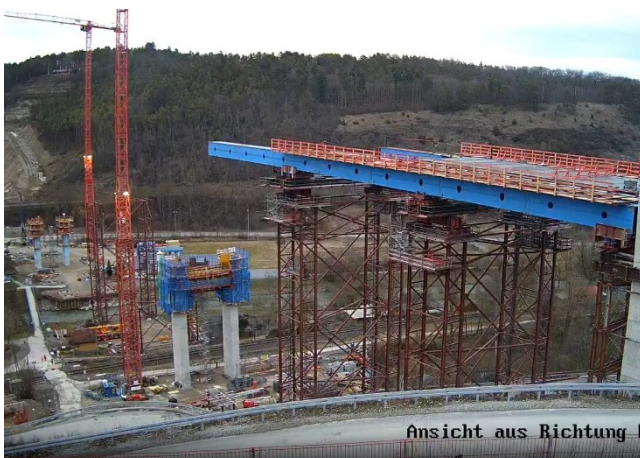
Hochbrücke Horb im Bau Quelle: SWR
