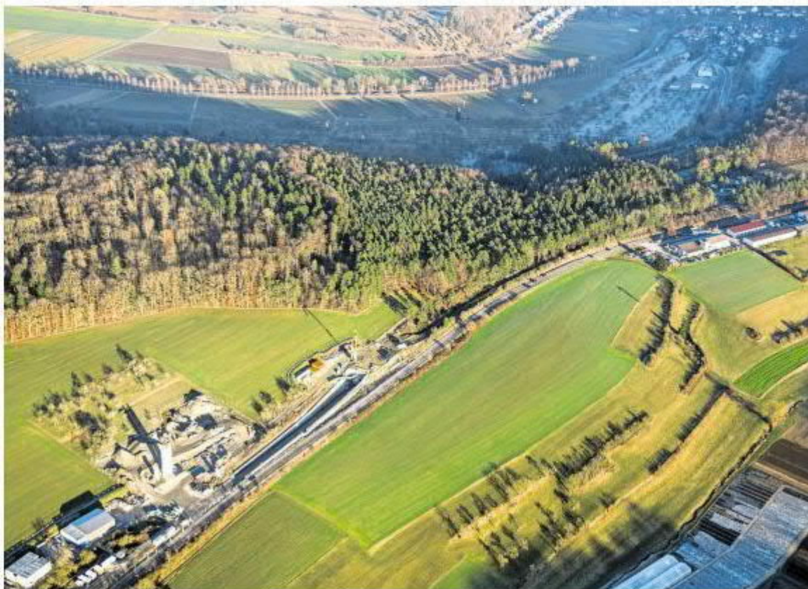
Der Iristunnel durch den Hacksberg (hier eine Aufnahme von 2021) ist das größte Teilprojekt der Hermann-Hesse-Bahn.
