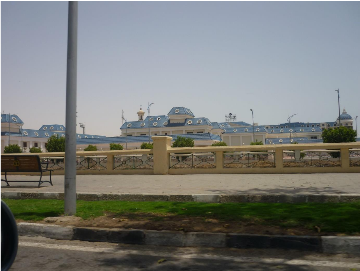
Gebäude in Kairo
