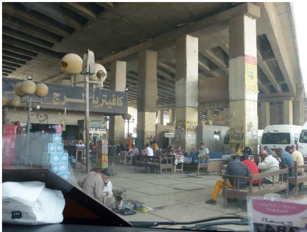
Endstation der U-Bahn am Stadtrand von Kairo
