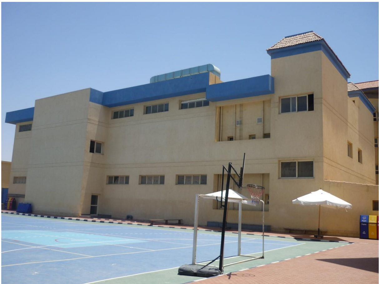
Sportgebäude von außen
